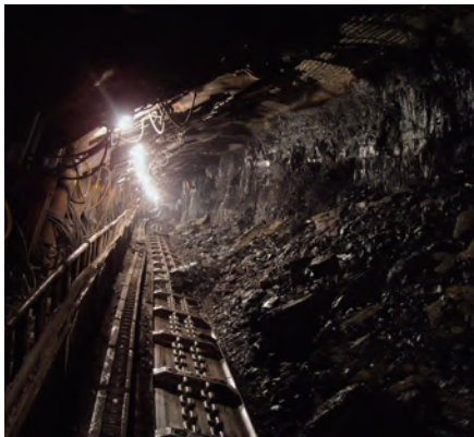
地下作業照明
